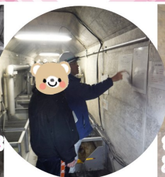
堤体から徐々に浸透してきた水の濁度・温度を測定
