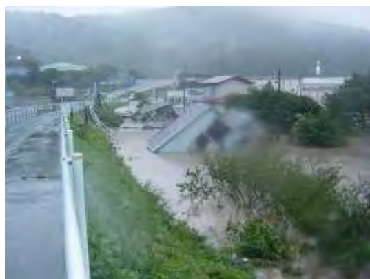
平成 19 年 9 月洪水による被災状況 (能代市二ツ井町 ヘルセンター付近)
