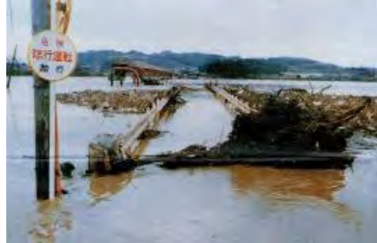
昭和 55 年 4 月融雪洪水による被災状況 (二ツ井町下田平)
