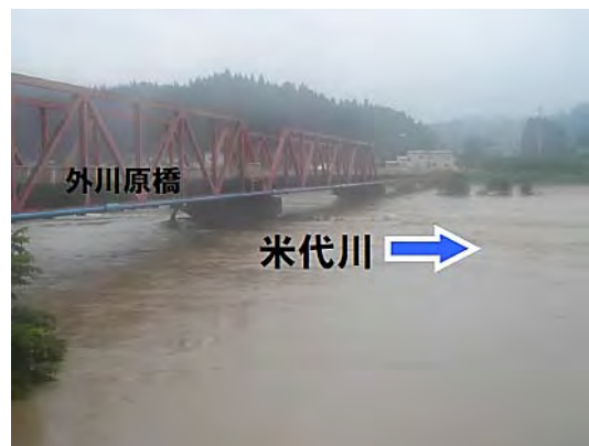
平成 25 年 8 月洪水による被災状況 (田代支所 外川原橋付近)
