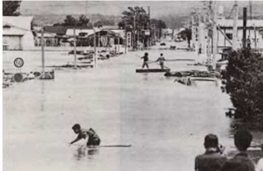
昭和 47 年 7 月洪水による被災状況 (能代市又右エ門橋付近)
