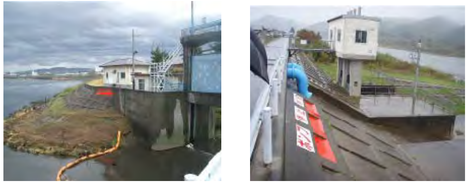
【悪土川・比井野川救急排水機場のポンプ停止水位表示】
