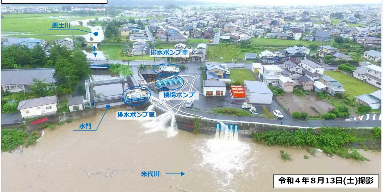
前日までに降り続いた雨により、米代川榊水位観測所(能代市下悪戸地内)の観測水位が上昇したため、能代市街地を流れる悪土川の内水被害を防止することを目的とし、悪土川救急排水機場を稼働、さらに排水ポンプ車も出動させ内水排除に努めました。
