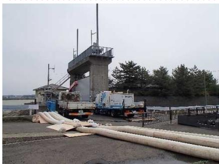
排水ポンプ車から河川の水を悪土川排水施設吸水槽への送水
