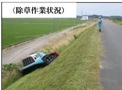
遠隔操作による大型除草機械作業が基本
