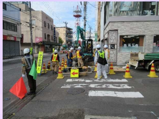
電線共同溝事業が進む国道7号長倉地区
