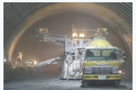
コンクリートを吹付けている様子
