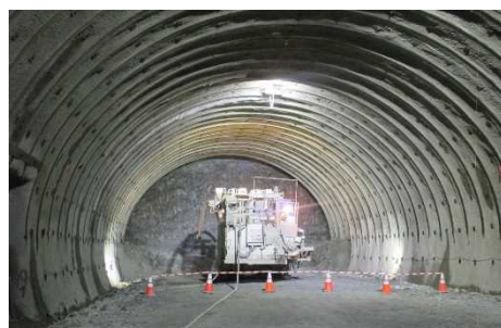
↑①から⑥の工程を施した状態
