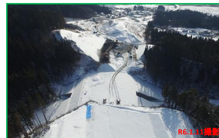
【No.520プレキャスト函渠部】 路床盛土工 完了
