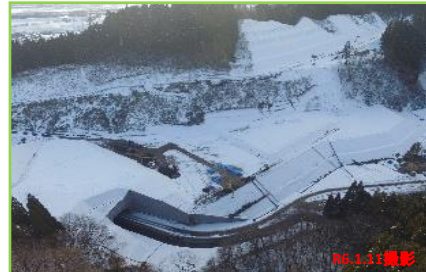
【今泉第二トンネル側土工部】 ・押え盛土 2/3段目完了 ・盛土排水工 施工中
