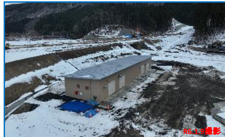
【電気室】 小繋電気室 完成
