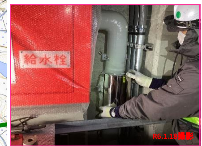
【今泉第二トンネル】 消火栓配管 保温作業状況
