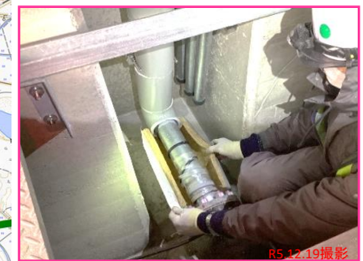
【今泉第二トンネル】 消火栓ヒーター取付・保温作業状況
