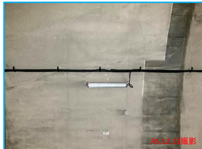
【小繋トンネル】 照明器具取付・配線完了
