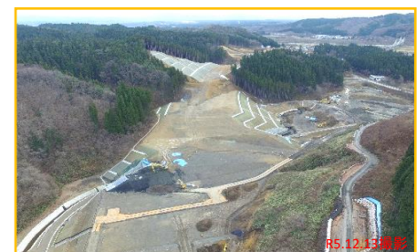
【大型函渠部】 路体盛土工 4段目まで完了
