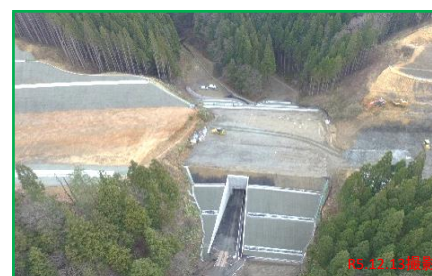
【No.520プレキャスト函渠部】 路床盛土工 施工中
