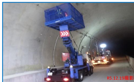
【今泉第一トンネル】 トンネル内ケーブル配線施工中
