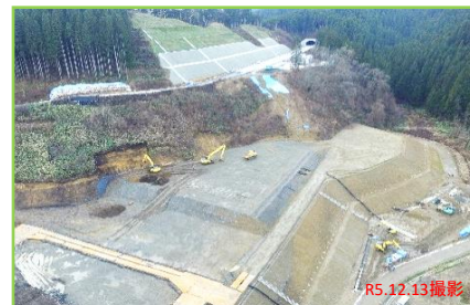
【今泉第二トンネル側土工部】 ・押え盛土 3/5段目完了 ・法面段切 施工中(遮水シート) ・盛土排水工 施工中
