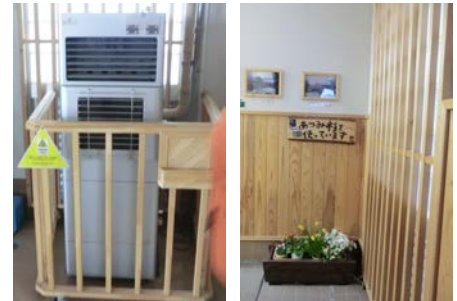
入り口横には冬季のみ、ベレットストーブが設置されています。冬に寒い！という声から置かれたのだそうです(左)。窓には格子を取り付けて程よく光をとり入れています(右)。
