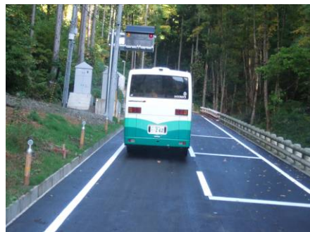
木製のガードレールとデリネーター（素波里ダム周辺）
