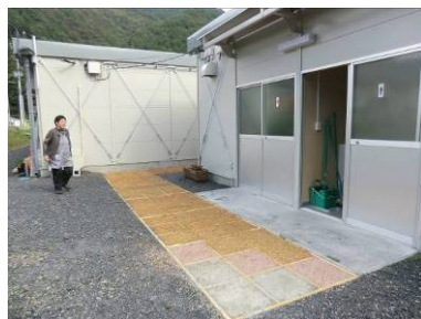
裏手のトイレ前は正方枠に入れる方法で材料も一部変更して実験施工しています。
