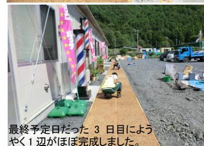
木枠の中に糊と混ぜたウッドチップを入れていき、上から転圧します。
