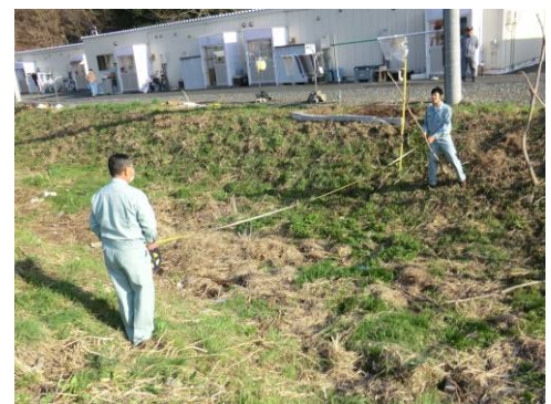
大槌町第 9 架設団地の建設予定地の測量
