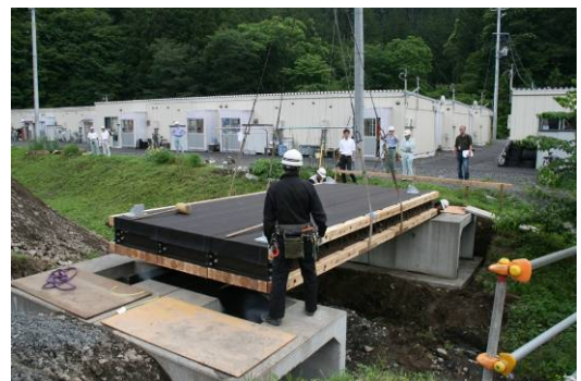
クレーンで橋台に設置 (黒いのは防水シート)
