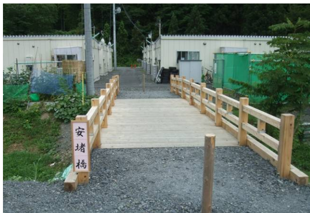
完成した安堵橋
