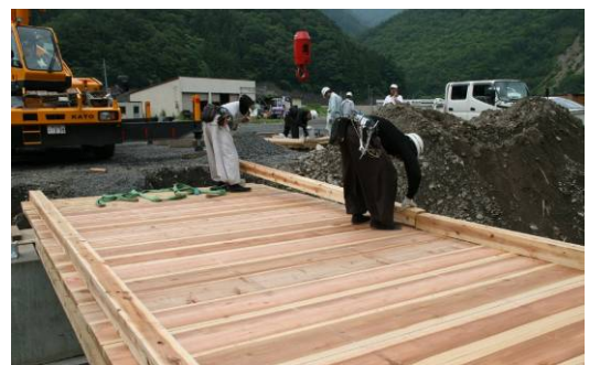
床板と縁木の設置で橋本体の完成 (ここまでで約5時間)
