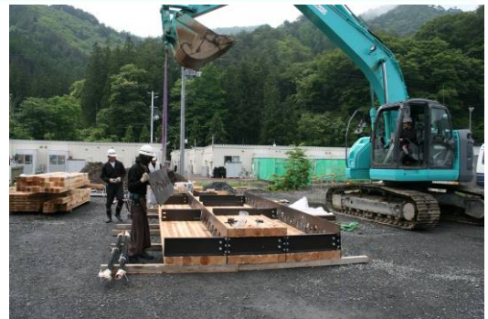
橋の組立開始 (仮設住宅前の駐車場で)
