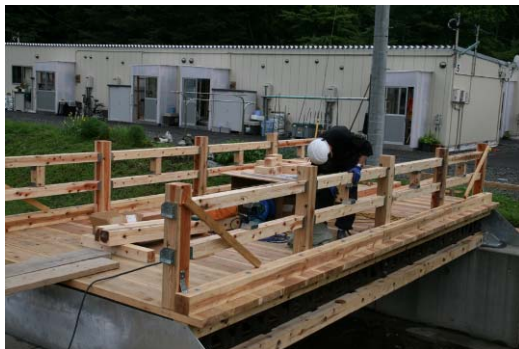
地元大工さんによる手すりの設置 (材料は地元産のスギ)
