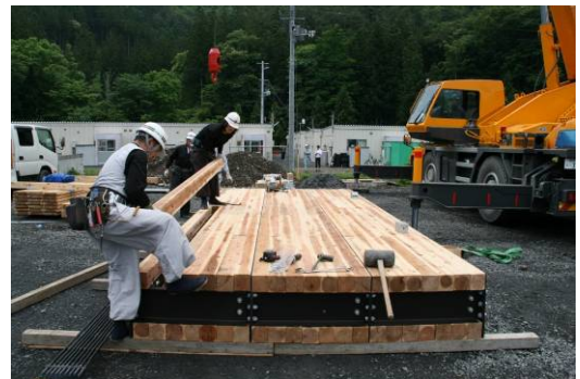
橋の組立完了直前 (ここまでで約2時間)
