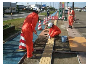
自転車走行帯が完成した後、歩行部のウッドチップ舗装を施工していきます。市販の視覚障害者用誘導ブロックを設置した両脇を舗装。
