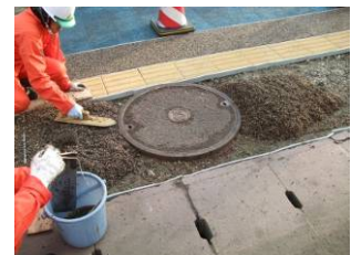
マンホール周辺も丁寧に仕上げられています。
