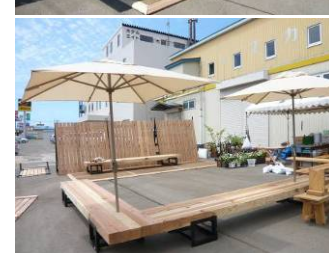
おなじみとなったウッドチップ舗装道の模型や屋根つきスギ塀、傘スギ縁台が並べられ、だんだんと木の香るイベント空間ができあがっていきます。
