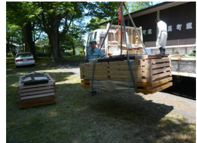
組み立てしやすいように、半分ずつに分けられたパーツを設置場所にクレーンで下ろします。
