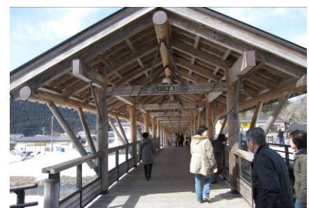
木材の良さを生かした屋根付き歩道橋「きごころ橋」。秋田でも造りましょう、佐々木先生。
