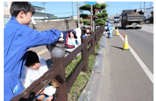
交通量のあるまちなかの国道7号。安全に配慮しながら作業を進めます。今年は担当場所によってローラーを使う板の箇所(上)と刷毛を使う丸太の箇所(下)がありました。
