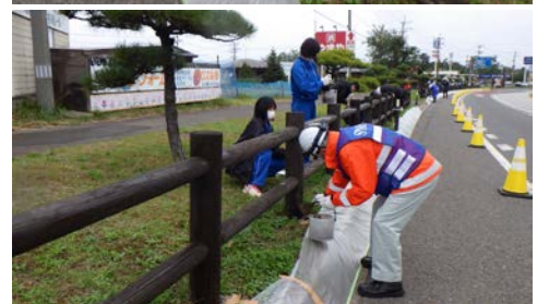
生徒は歩道側(上)、大人は道路側(下)を塗装しました。
