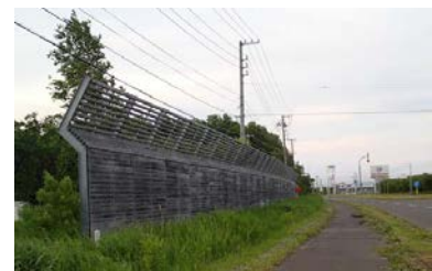
石狩市郊外に設置されている防雪柵の木材は全て半割り丸太を使用しています。
