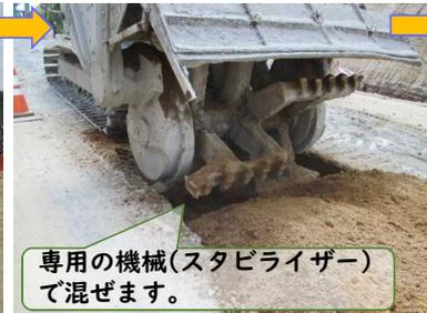
専用の機械(スタビライザー)で混ぜます。
