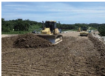
ICT建設機械施工(無人) *3
