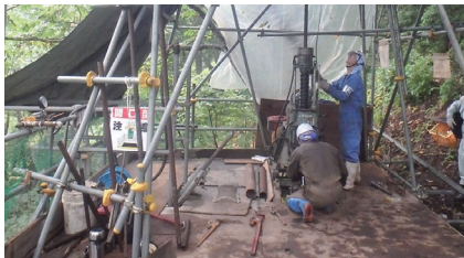
ボーリング調査
