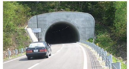
付替道路工事(成瀬ダム)
