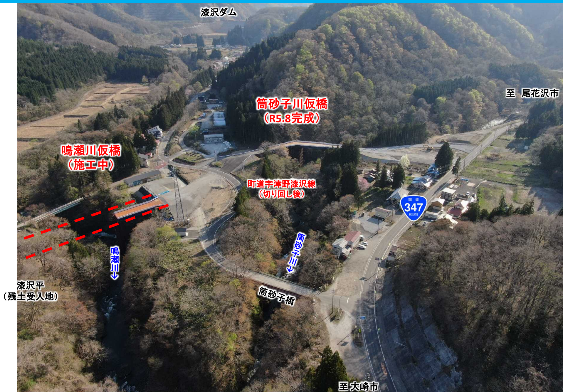
町道宇津野漆沢線切り回し部・筒砂子川仮橋・鳴瀬川仮橋 整備状況 (令和6年4月15日撮影)
