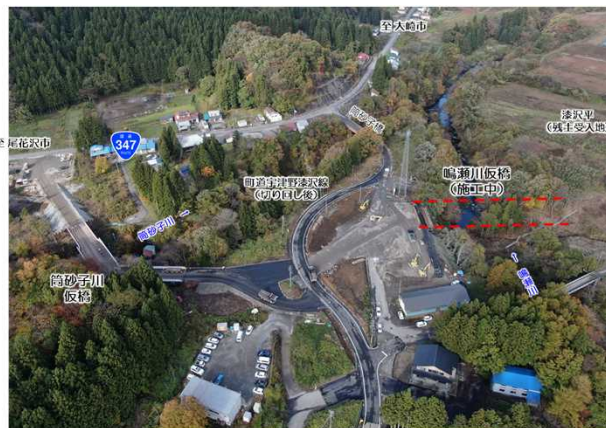
工事箇所（令和5年11月撮影）
