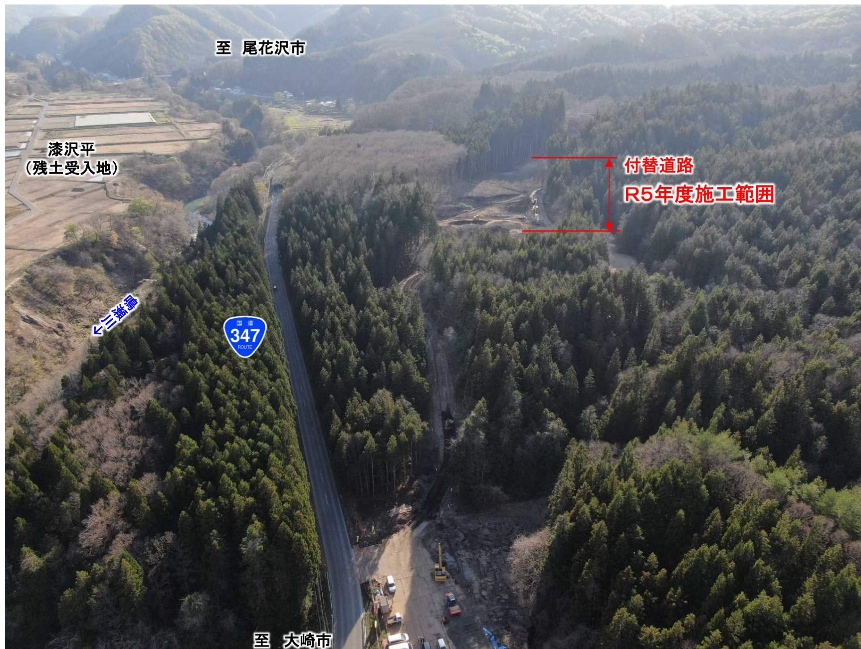
付替道路工事用道路 整備予定箇所 (令和6年4月15日撮影)
