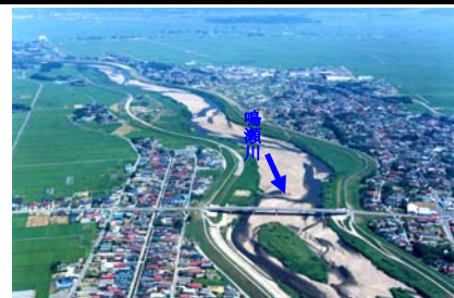
写真 2-12 平成6年渇水 木間塚大橋（鳴瀬川14.0k付近）の状況
