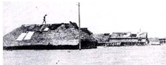
写真 2-6 洪水被害状況 吉田川 旧鹿島台町(大崎市)にて 堤防決壊と品井沼の溢水で浸水
