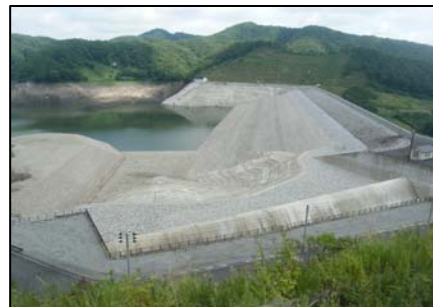
写真 2-22 ニツ石ダム貯水池の状況 (平成 24 年 9 月 4 日)
