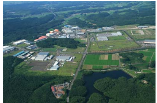
写真 2-10 仙台北部工業団地
