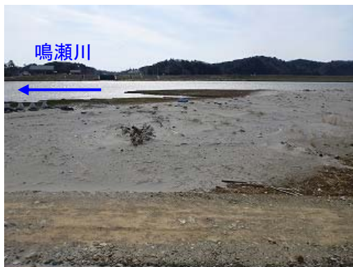
写真 2-37 河口部左岸高水敷の状況
