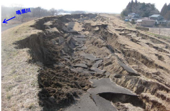
写真 2-25 鳴瀬川左岸 30.3k 付近
