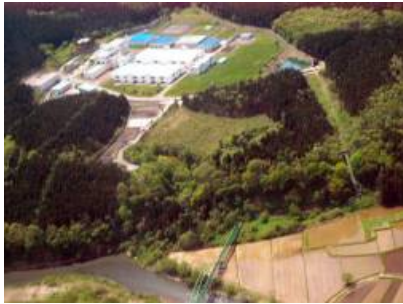
写真 2-8 ふもとやま 籠山浄水場
