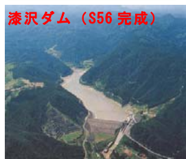
漆沢ダム (S56 完成) 宮城県 (供用中)
