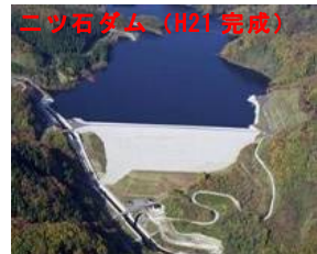
ニツ石ダム (H21 完成) 農林水産省 (供用中)
