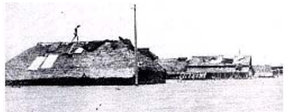
写真 2-6 洪水被害状況 吉田川 旧鹿島台町(大崎市)にて 堤防決壊と品井沼の溢水で浸水
