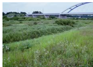
写真 2-29 背割堤防区間の植生状況
