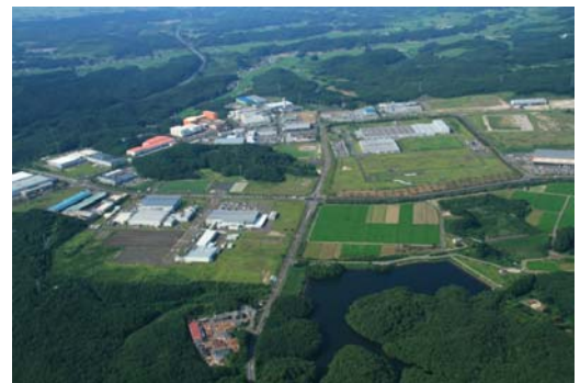
写真 2-10 仙台北部工業団地
