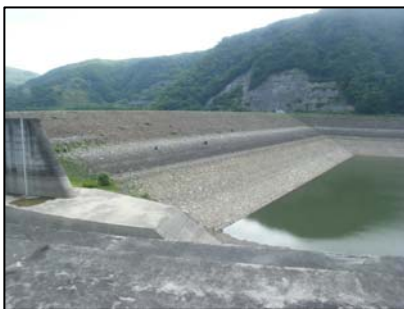
写真 2-21 漆沢ダム貯水池の状況 (平成 24 年 9 月 4 日)
