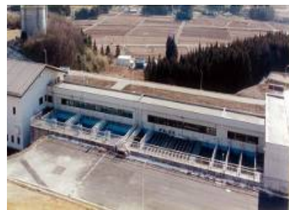
写真 2-9 なかみね 中峰浄水場
