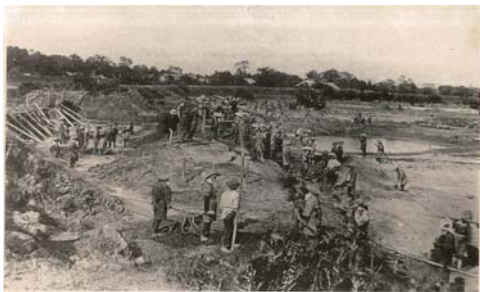
写真 2-3 明治43年8月洪水 鳴瀬川 旧三本木町(大崎市) にて堤防決壊箇所を修復する様子
