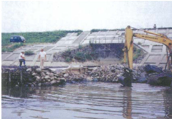
写真 2-16 かんがい取水口前面の堆積土砂 撤去作業 旧南郷町（美里町）
