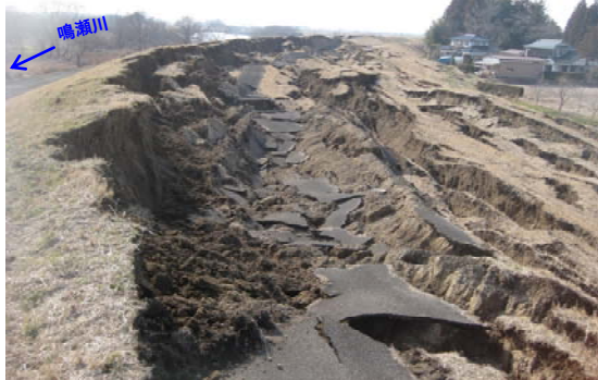
写真 2-25 鳴瀬川左岸 30.3k 付近
