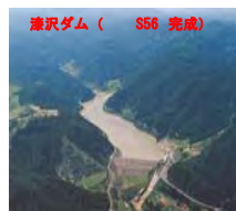
宮城県(土木)施工
