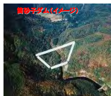
宮城県(土木)施工
