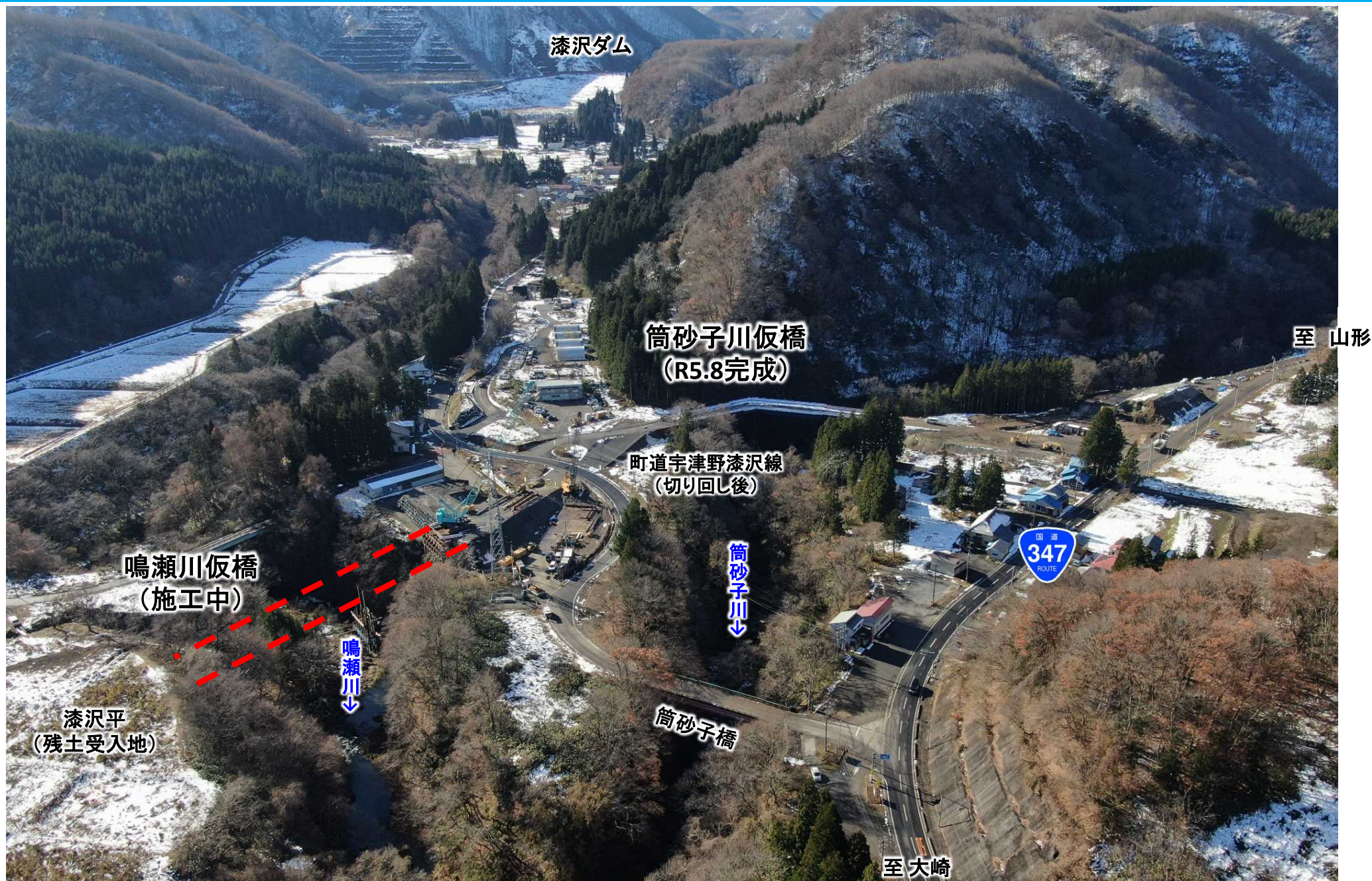
町道宇津野漆沢線切り回し部・鳴瀬川仮橋施工状況 (令和5年12月4日撮影)
