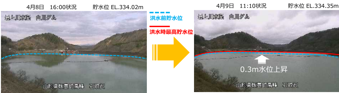
白川ダム貯水状況
