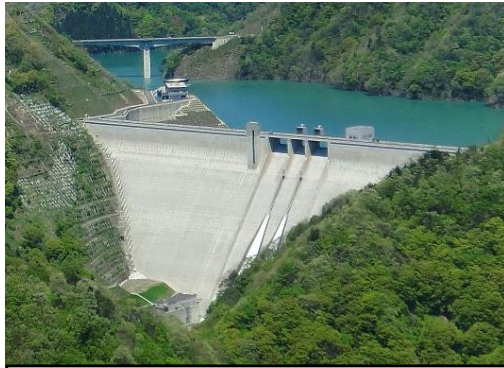
長井ダム洪水吐からの放流
