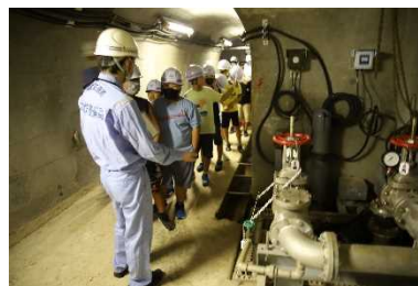
（堤体内での点検・計測）
