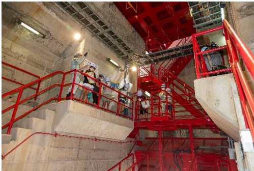
（機械設備（ゲート）の点検）
