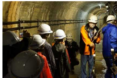
（堤体内での点検・計測）
