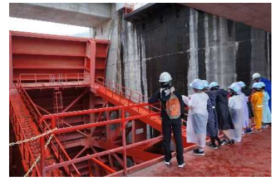
（ゲート設備点検）
