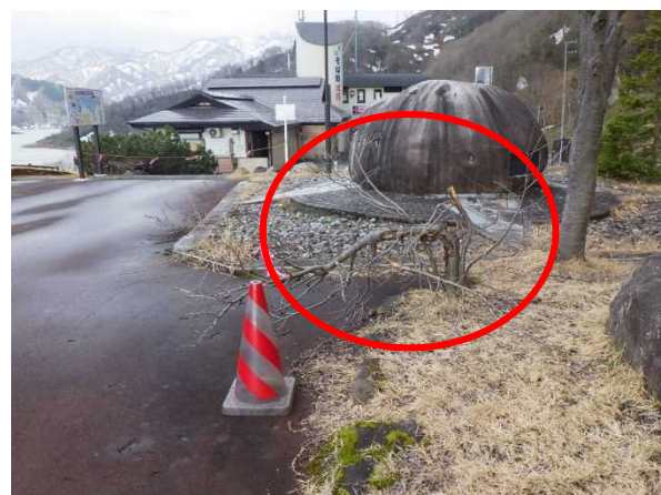
樹木折れ 応急対策状況(砂子関展望広場)
