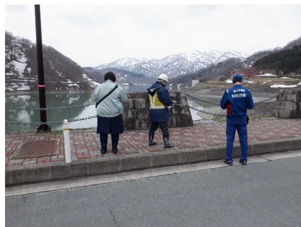
寒河江ダムの点検実施状況(ダム天端)
