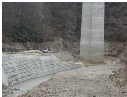
(土砂撤去後の状況)
