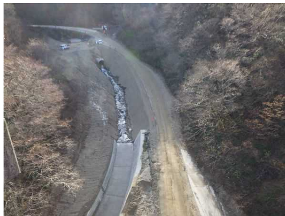
(管理用道路盛土応急復旧状況)
