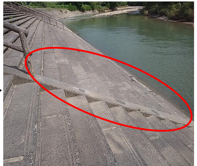
階段護岸にあった流木等の堆積物、手すりの一部破損(白川ダム・湖岸公園)
