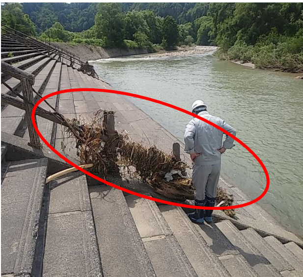
階段護岸にあった流木等の堆積物、手すりの一部破損(白川ダム・湖岸公園)
