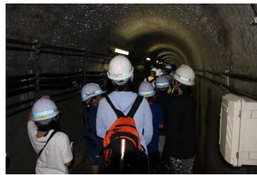
（堤体内での点検・計測）
