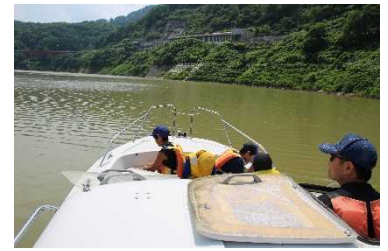
（巡視船による貯水池巡視）
