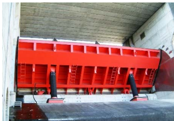
ゲート下流側
