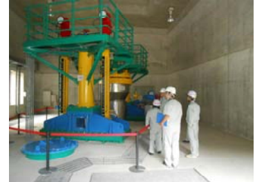
長井ダム堤体巡視体験
