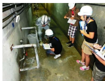
（堤体内での点検・計測）
