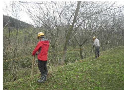
補修（トラロープ張り替え）
