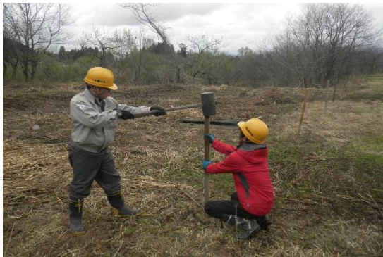
補修（木杭再設置）
