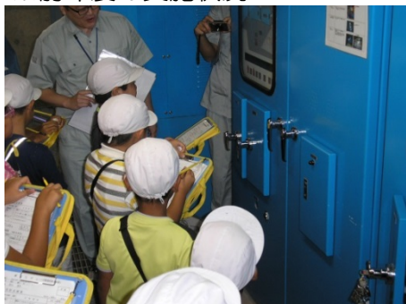
（機械設備の点検）
