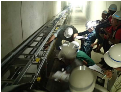
（監査廊内で点検計測）
