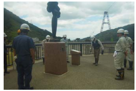
↑長井ダム堤体・管理庁舎周辺点検状況
