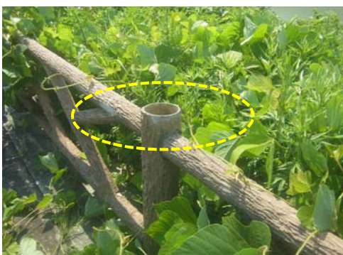
↑点検時の状況
