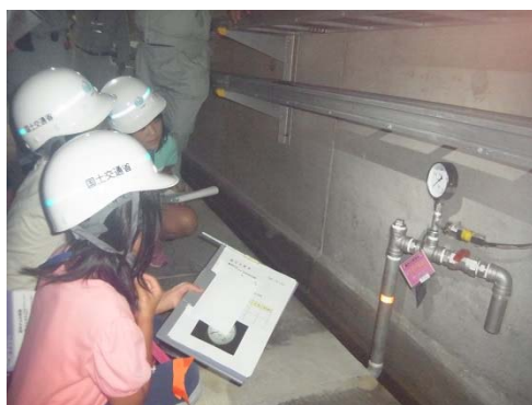
（監査廊内で点検計測）
