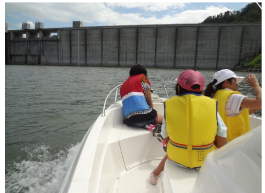
（巡視船による貯水池巡視）
