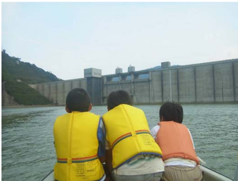
(巡視船による貯水池巡視)
