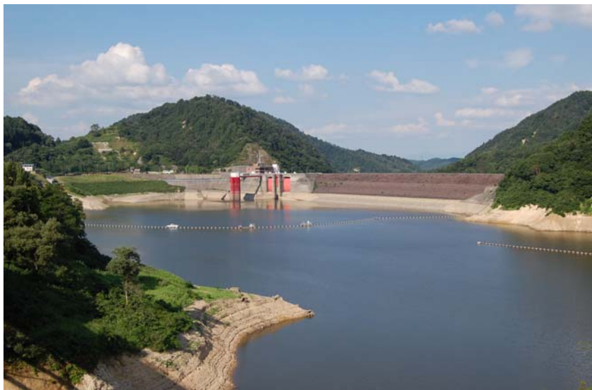
白川ダム貯水池状況写真（平成24年8月23日現在）
