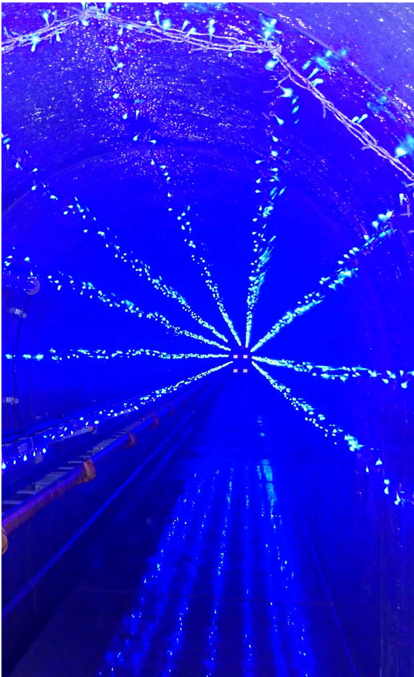
「監査廊のイルミネーション」 長井ダム
